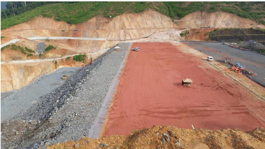
*Figura 1: Barragem sendo alteada*
